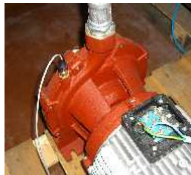
Joonis 3. Rõhuanduri montaaž pumbale
